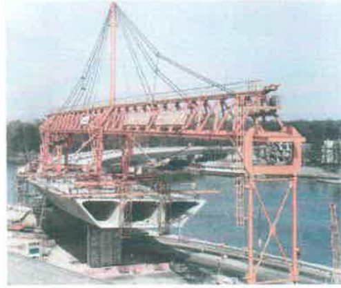
Viaduc de Saint-Cloud 1973
