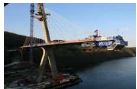
Chantier du nouveau pont
