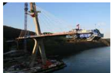
Chantier du nouveau pont
