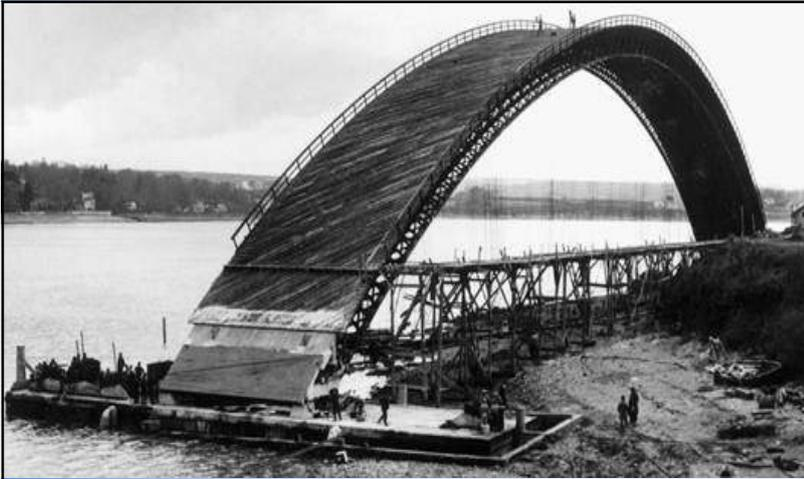
Mise en tension des câbles de sous-bandage puis mise en flottaison du cintre sur ses deux chalands
