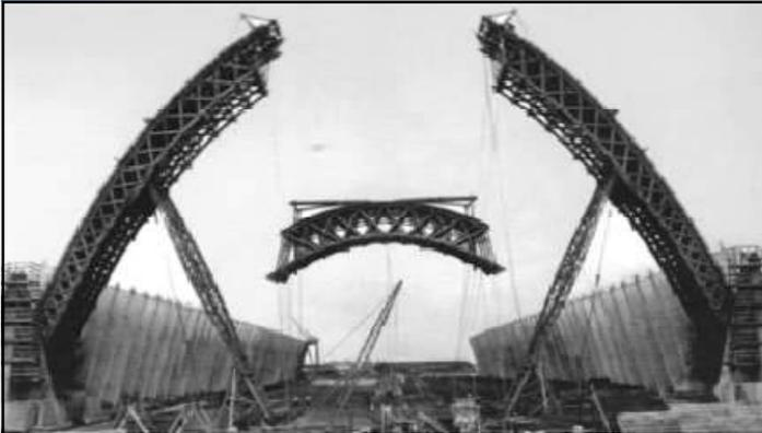
Assemblage des trois éléments du cintre et son équipement avec ses quatre grues et les coffrages
