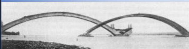
Le décentrement de chaque arc est réalisé, comme Eugène FREYSSINET en avait maintenant la parfaite maîtrise, par la mise en pression des 24 vérins de 250 tonnes disposés à la clé de ces arcs.
