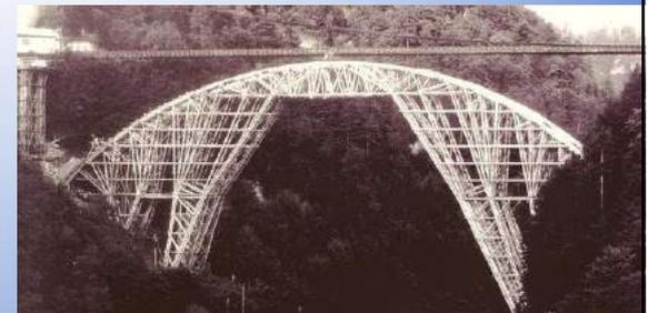
Comme nous l'avons vu, les poussées horizontales se développent au fur et à mesure que la charge verticale s'applique, Donc, lors du décentrement, au fur et à mesure que le cintre se décharge, le poids du béton se transmet à l'arc en le comprimant et en développant ses poussées horizontales au droit des culées. C'est ainsi que s'effectue ce transfert de charge du cintre à l'arc.
