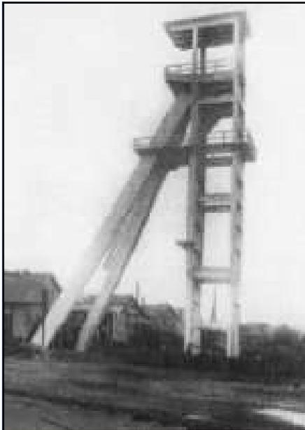
Le chevalement de la Mine de Noyant d'Allier construite en 1923, un des premiers chevalements en béton armé
