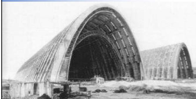
Chaque hangar est constitué de quarante arches s'élevant directement à partir du sol, dont « la forme parabolique, esquissée par son intuition, précisée par son calcul, dérivait de la fonction structurelle et des possibilités des matériaux et des moyens d'exécution ». Ces arches, formant nervure pour l'ensemble de l'ouvrage, de section rectangulaire évidée, étaient renforcées par des tirants à l'intérieur des voûtes pour améliorer le comportement général de l'ouvrage au vent.
