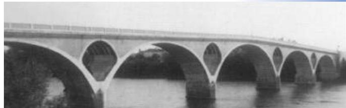
le **Pont de Tonneins** en 1922, comportant cinq arches de 46 m de portée surmontées d'autres arches de décharge,
