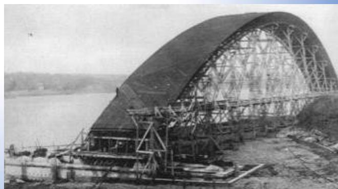
Installation sur le cintre d'un platelage supportant le coffrage
