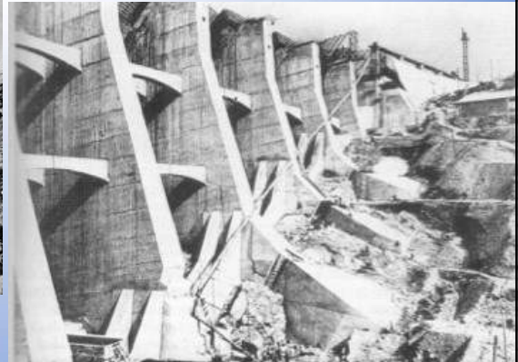
Barrage de Beni-Badhel (face amont) Contreforts du Barrage de Beni-Badhel avec ses massifs de butée (face aval)
