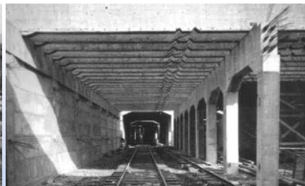
Ouvrage en cours de construction
