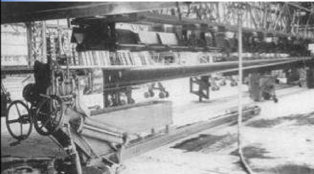
Machine fabricant le mandrin en caoutchouc servant de coffrage intérieur gonflable
