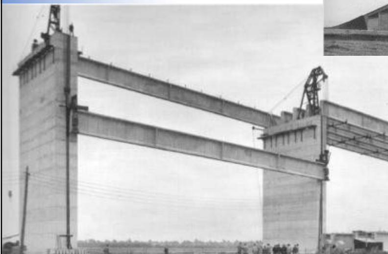
Hissage d'une poutre à l'aide des deux potences
