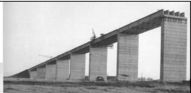
Vue d'ensemble de l'ouvrage
