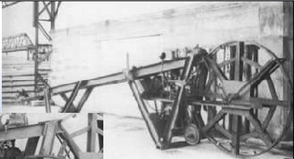
Machine permettant d'élever la limite élastique des aciers
