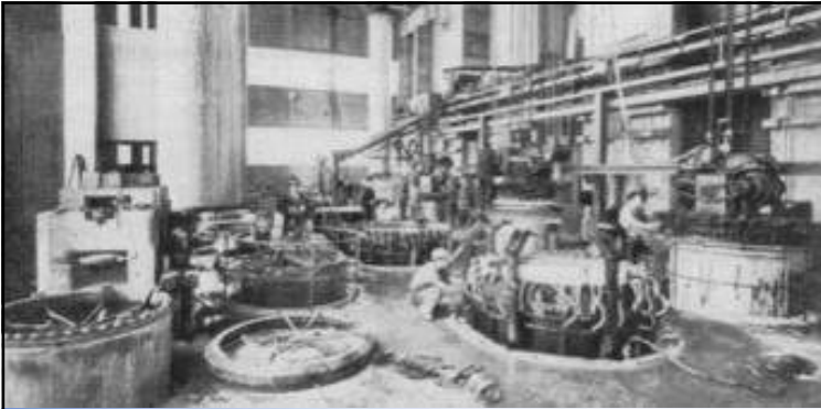
Vue de l'intérieur de l'usine de fabrication des tuyaux précontraints
