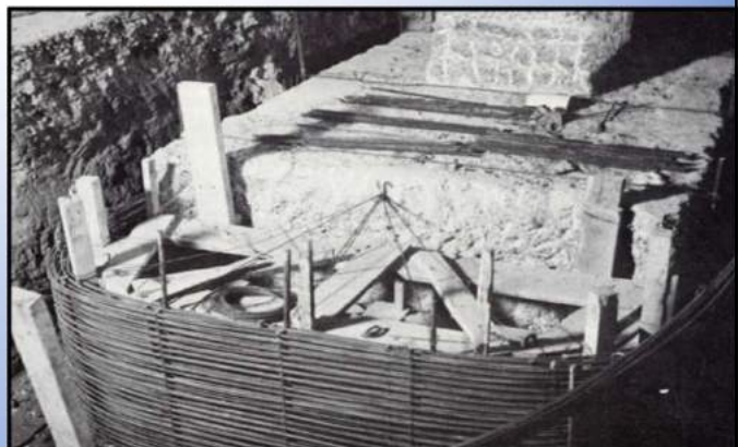
Détails des têtes d'ancrage à une extrémité de ces longrines mises en précontrainte par vérins hydrauliques
