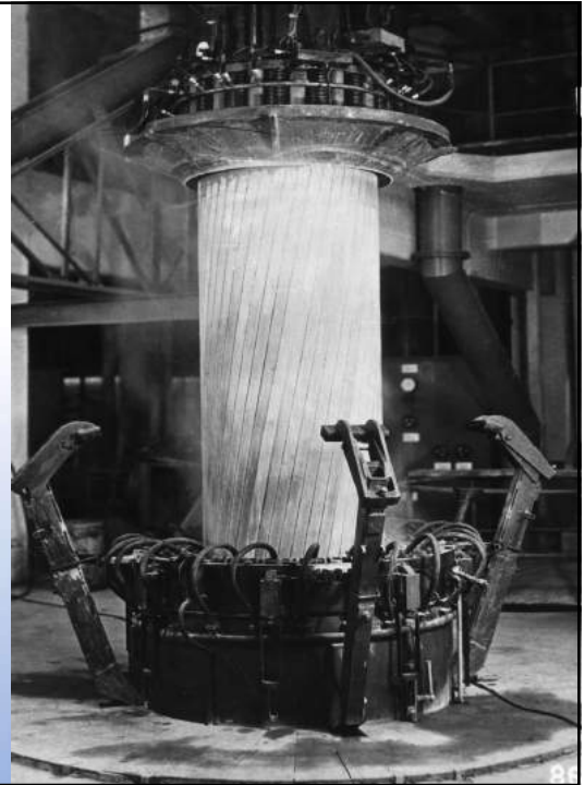
Sortie de son moule d'un tuyau précontraint
