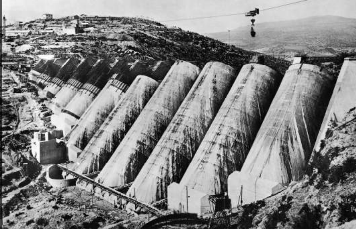
Barrage de Beni-Badhel (face amont) Contreforts du Barrage de Beni-Badhel avec ses massifs de butée (face aval)
