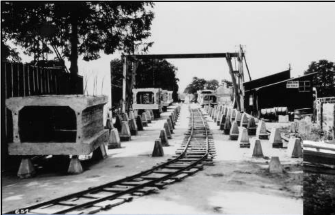
Préfabrication des voussoirs
