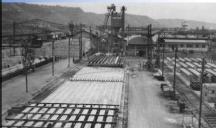
Chantier de préfabrication des éléments
