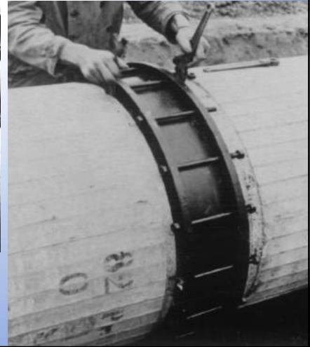
Assemblage par brides boulonnées des tuyaux précontraints
