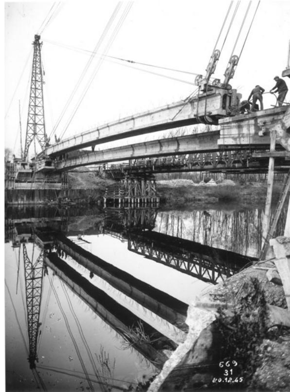
... le chantier fut repris en 1945, et terminé en 1946, les voussoirs préfabriqués étant alors préassemblés par précontrainte pour former des poutres de 60 m de long et pesant 90 t posées à l'aide de câbles et poulies accrochés à deux pylônes en bois cloués de 24 m de hauteur
