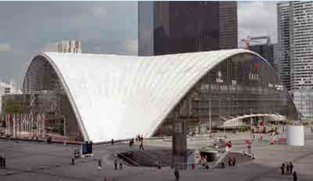
La coque de couverture du CNIT à La Défense conçue par Nicolas Esquillan
