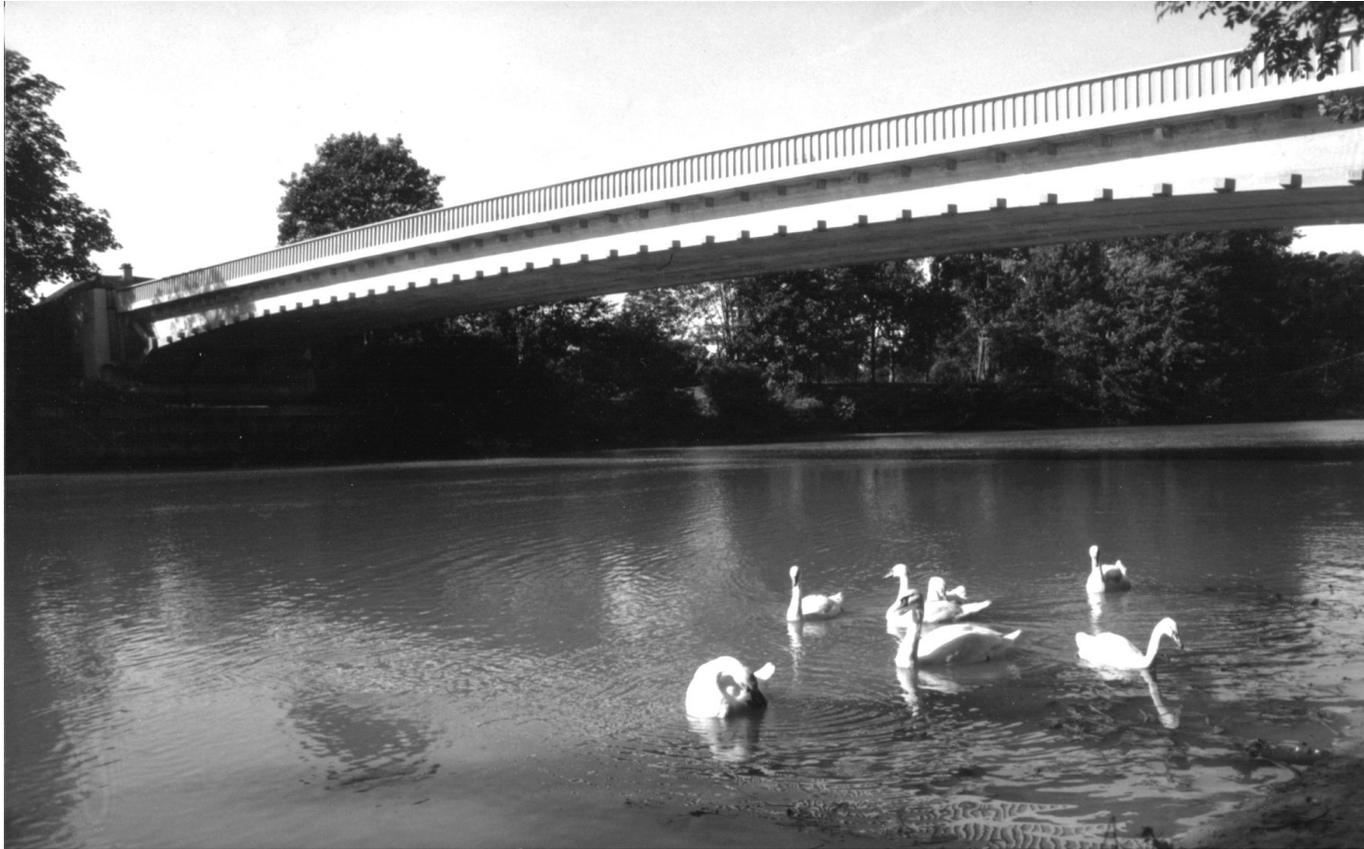
Le pont de Luzancy est le premier ouvrage préfabriqué en béton.
