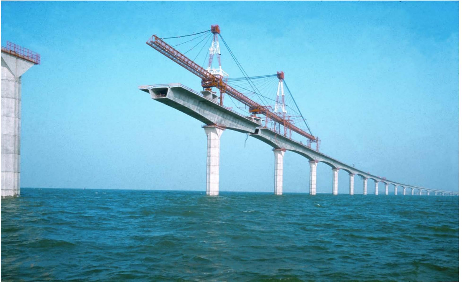
Pont de l'Île de Ré construit en 1987-1988 selon le principe du Pont de Luzancy
