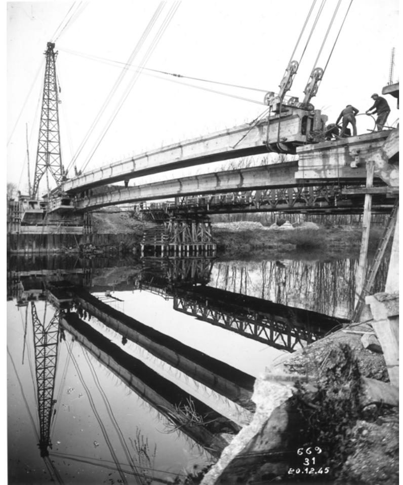
Pont de Luzancy, 1941-1946. Préfabrication et mise en place des éléments du pont.
