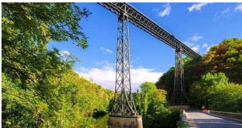
Le pont de Rouzat sur la Sioule entre Bègues et Saint-Bonnet-de-Rochefort (Allier)
