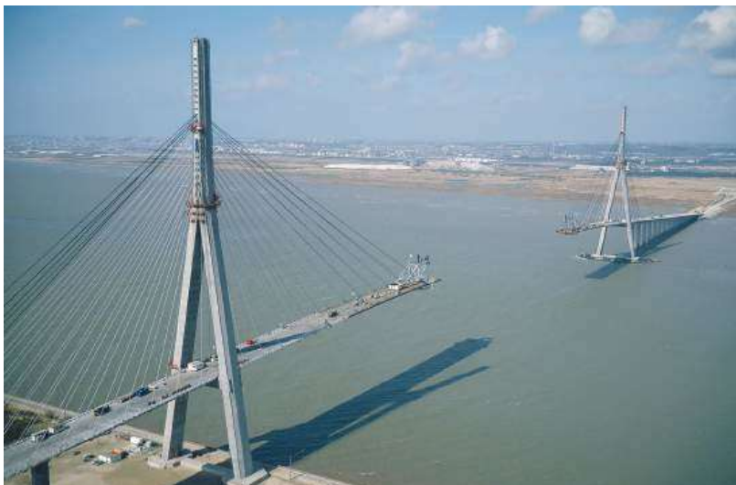
Construction du pont de Normandie en 1994 (inauguré en 1995, ce pont a longtemps détenu le record du monde de portée des ponts à haubans avec une travée centrale de 856 m)
