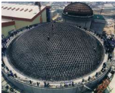
Construction de la centrale nucléaire de Daya Bay (Shenzhen – Chine près de Hong Kong). Mise en service en 1993
