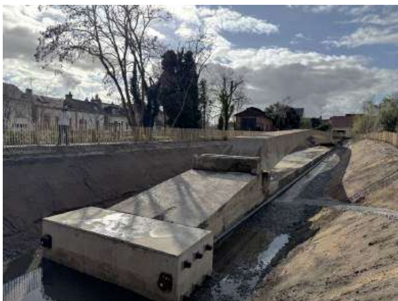
Vue de l'arche sauvegardée en avril 2026
