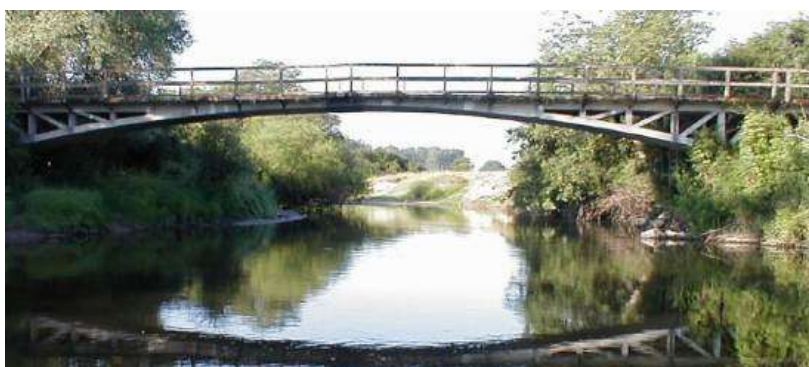
Le pont de Prairéal à Vaumas (Allier)
