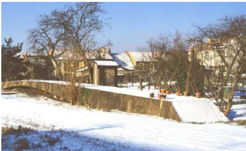
Arche de Moulins (avant restauration)
