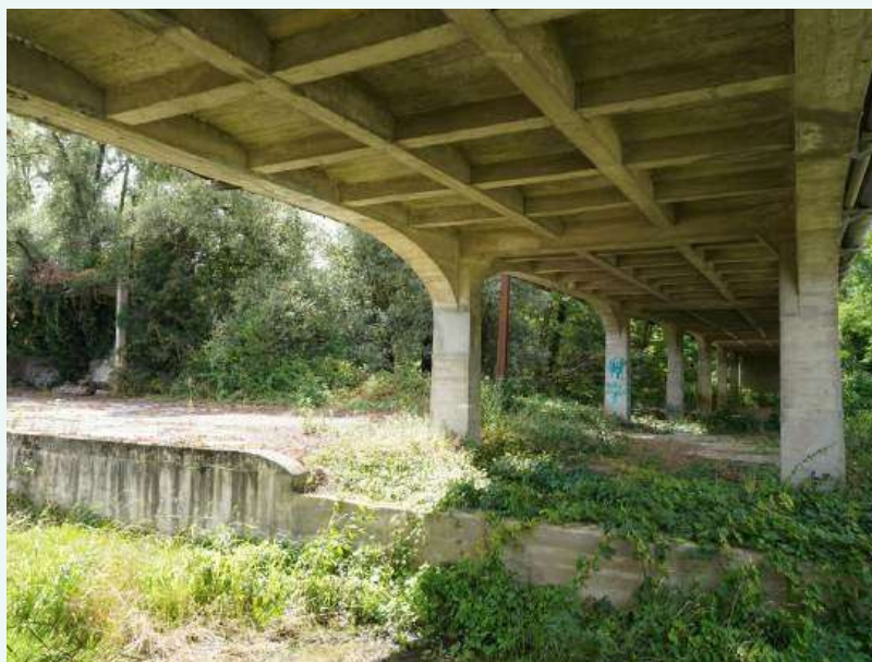
Dalle nervurée en sous-face
