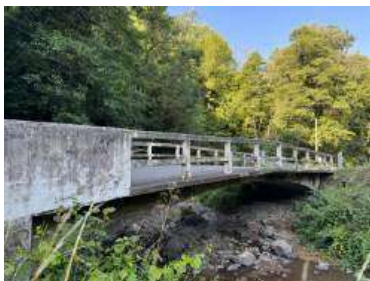
Pont des Malavaux à Cusset
