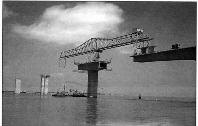
d'appuis, la poutre est lancée à la pile suivante pour permettre la construction d'un nouveau fléau. Progressant ainsi d'appui en appui de façon indépendante des difficultés du site (relief montagneux accidenté, courants ou marées), la pose du tablier s'opère de façon régulière, rapide et économique.
