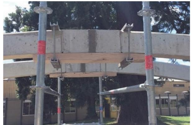
Le démontage des brelages le 07/07/2017 a entraîné la mise en compression des joints et la stabilité définitive des 2 arcs jumeaux.
