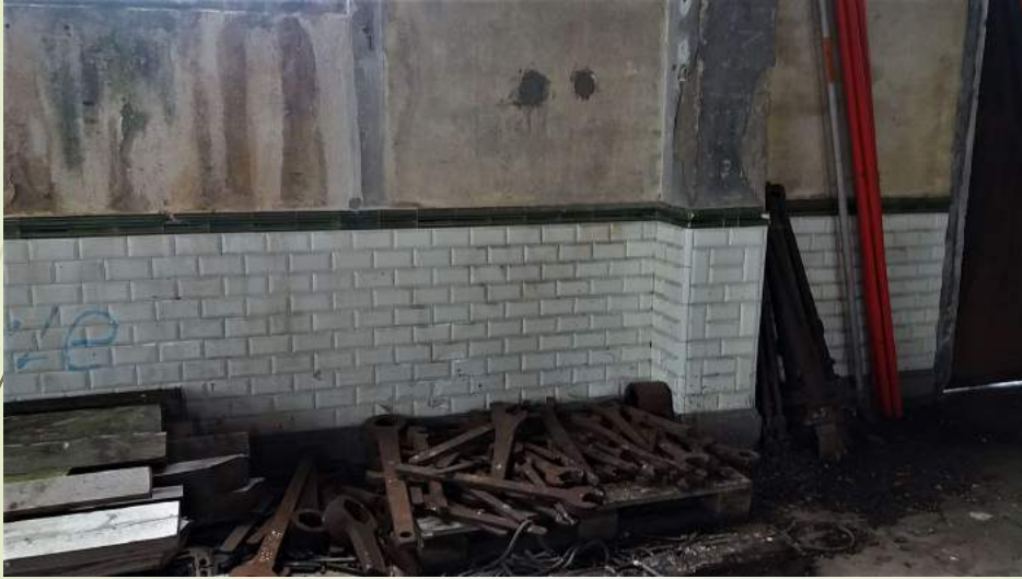
Détail des parois
