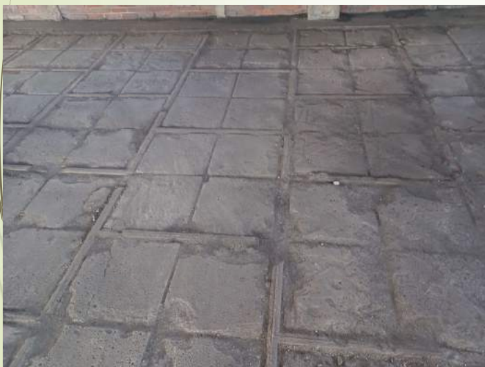
Détail du plancher
