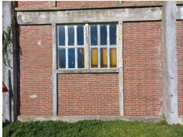
Trame de la salle des machines
