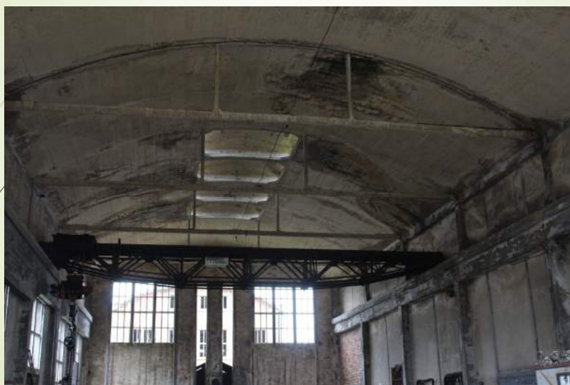
Voute et pont roulant
