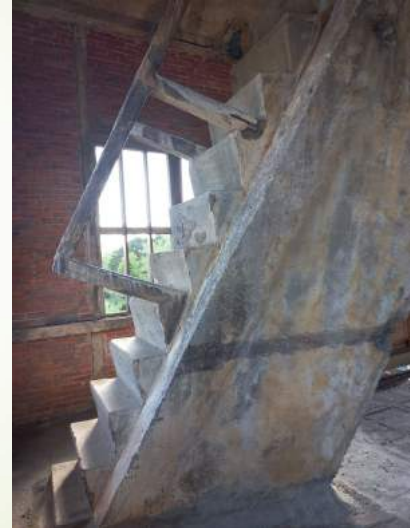
Départ de l'escalier du chevalement
